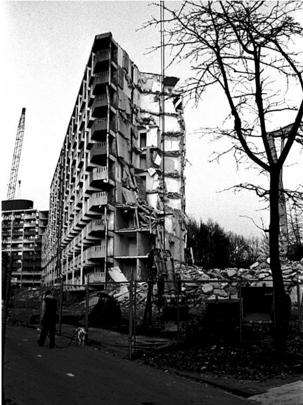
Figure 17 : Démolition d'un bâtiment du quartier résidentiel de Bijlmermeer, Pays-Bas, circa 1990 – photo : Pieter Boersma
