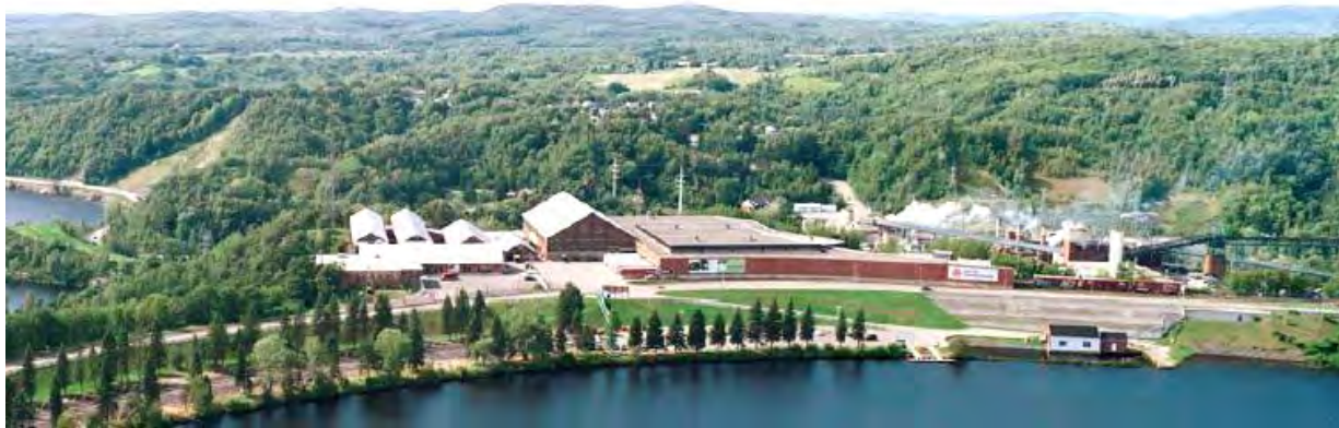
Figure 9 : Vue d'ensemble du Complexe Alcan
