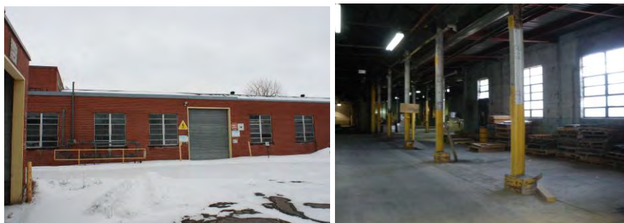
Figure 27 : État actuel – Bâtiment 1957 (extérieur/intérieur)
