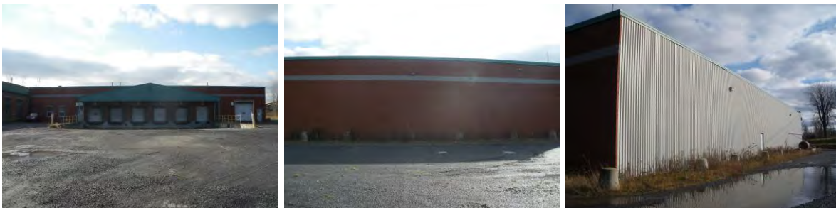
Figure 23 : État actuel - Façade est, murs nord et ouest
