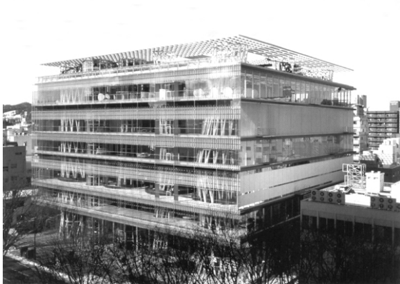
Figure 22 - Médiathèque de Sendai : Toyo Ito
